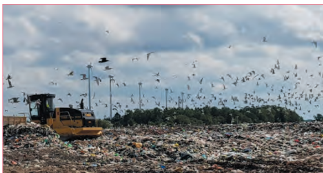
Фото 1. Каток TANA на полигоне
